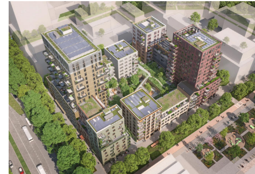
Dakoppervlak van bouwblok 2A ©GROUPA
